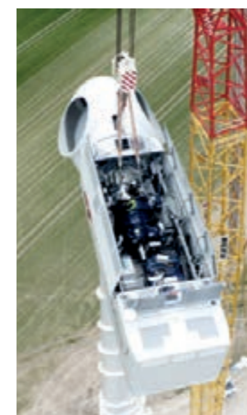
Figure 77 : opération de maintenance sur une nacelle (source : EDPR/C.laprod)
