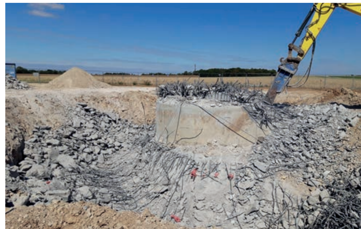
Figure 78 : démantèlement des fondations d'une éolienne sur un parc EDPR (source : EDPR/Direct Image)
