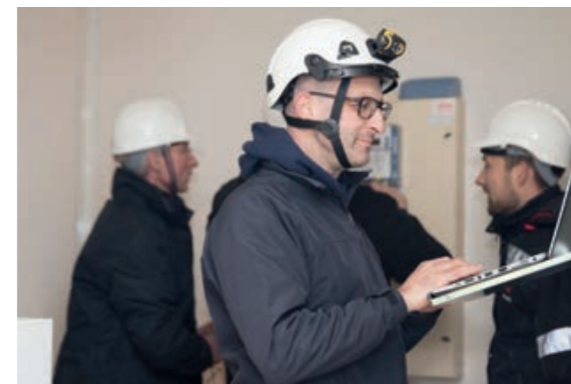
Figure 75 : intervention de maintenance sur un site éolien (source : EDPR)
