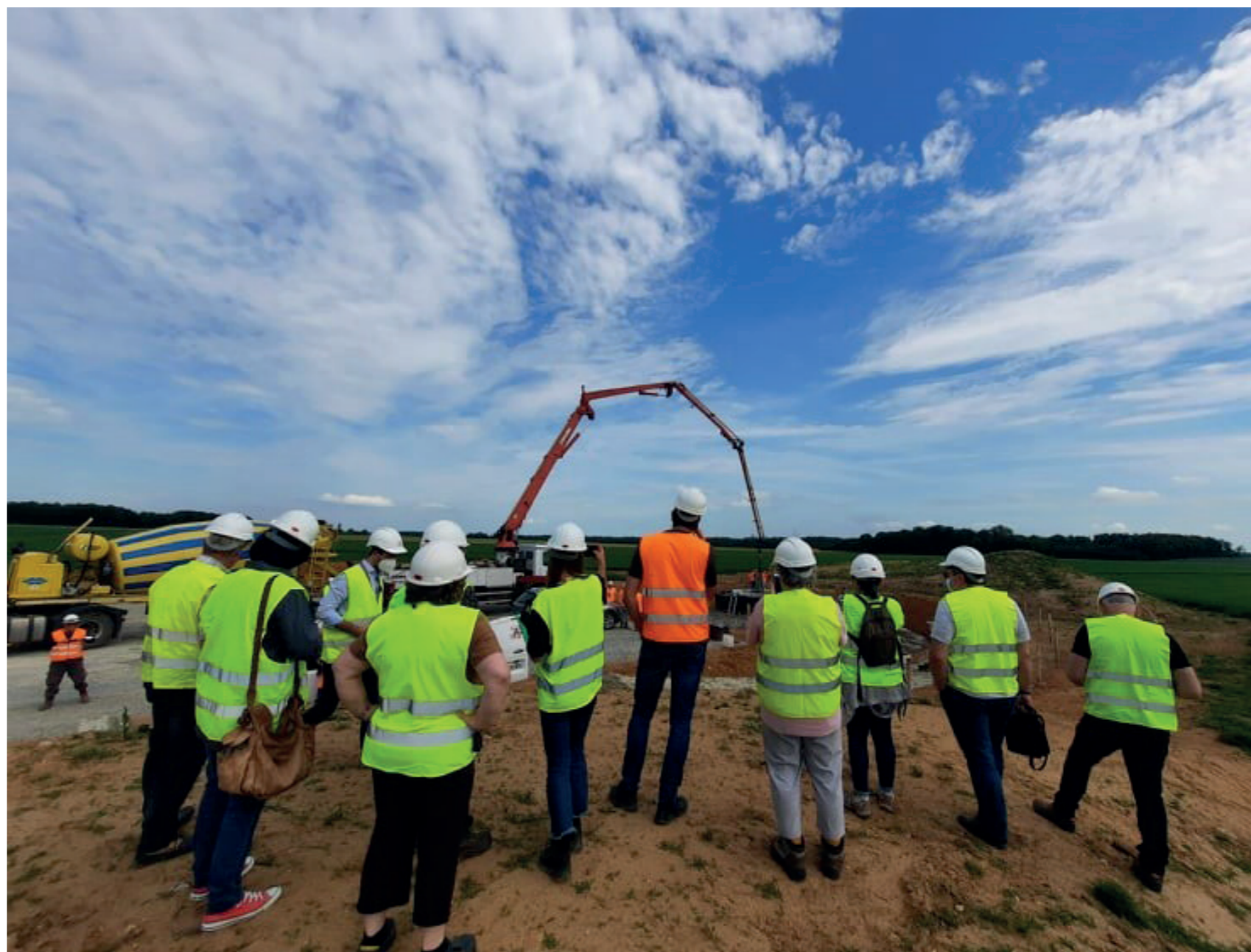
Figure 38 : visite du chantier du parc éolien de Roman-Grandvilliers sur la commune de Mesnil-sur-Iton avec les élus de Burey en juin 2021 (source : EDPR)
