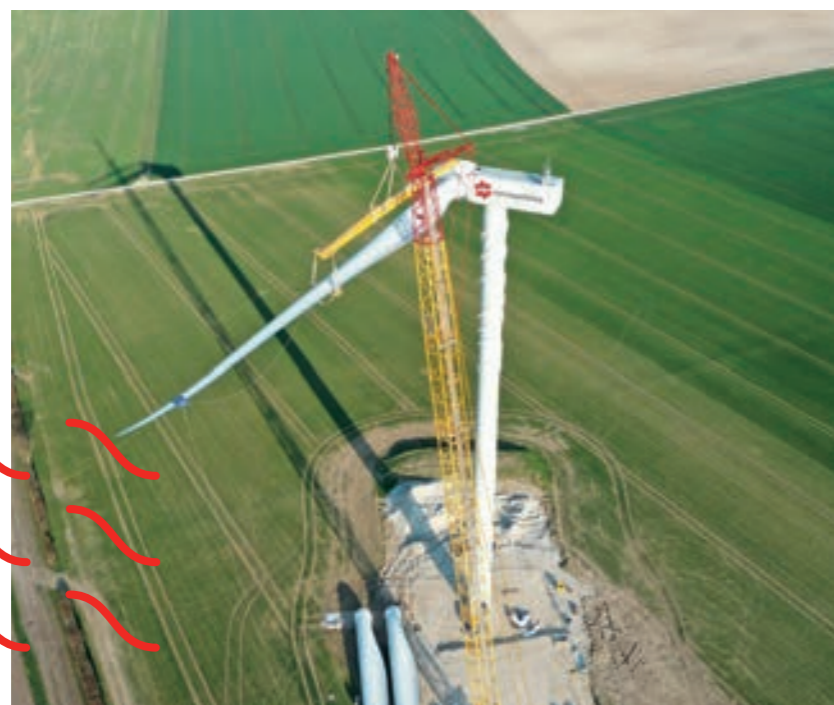
Figure 66 : levage d'une éolienne au parc de la Côte-du-Cerisat dans la Marne (source : EDPR)
