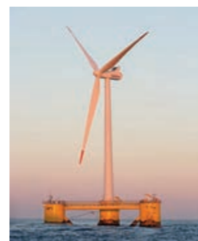
Figure 3 : prototype d'éolienne flottante mise en service au Portugal (source : EDPR)
